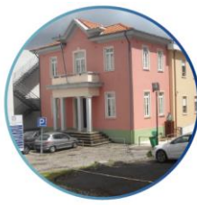
Hospital Nossa Senhora da Conceição de Valongo
