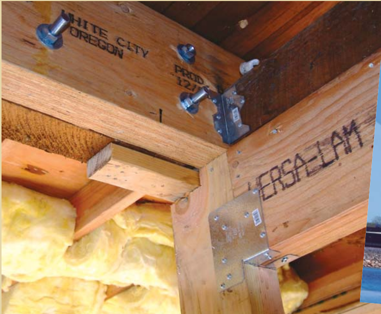
Mode de construction permettant d'accroître la résistance d'un bâtiment aux séismes - FEMA/Adam Dubrowa
