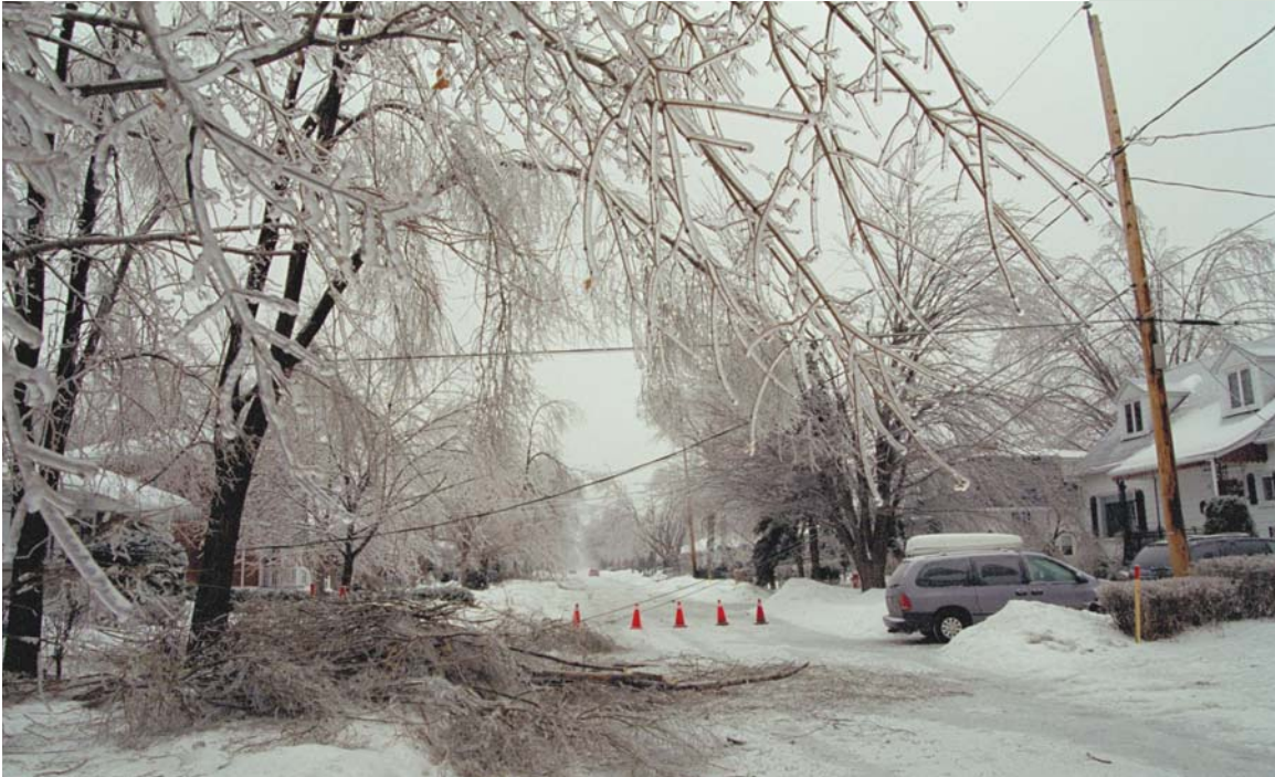
Sud-ouest du Québec, janvier 1998 - Hydro-Québec
