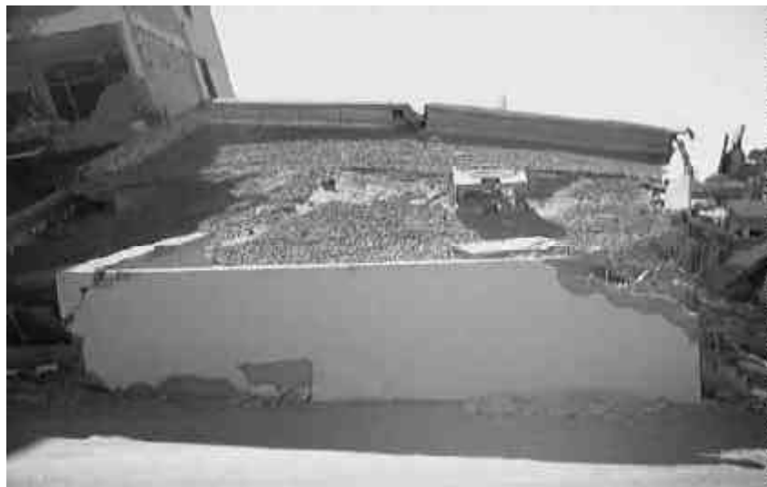
Casa danificada por um terremoto em Zenouri – Argel, Argélia (Maio de 2003)
