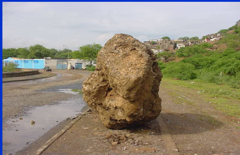
Desprendimento de um bloco – L. Ferreira
