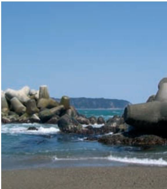
Les vagues perdent beaucoup en puissance lorsqu'elles viennent frapper des brise-lames de ce type, construits pour protéger un port sur la côte Pacifique
