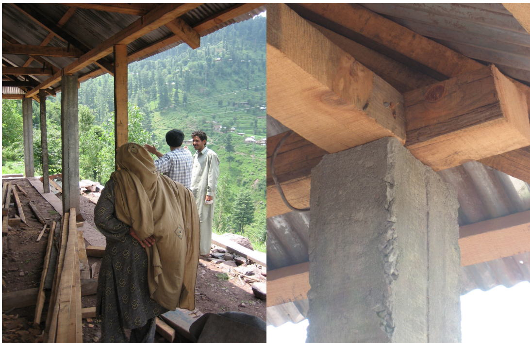
Фото № 8. Восточная окраина жилого района рядом с горами. Наклонная местность. Новая строительная площадка (после землетрясения).
