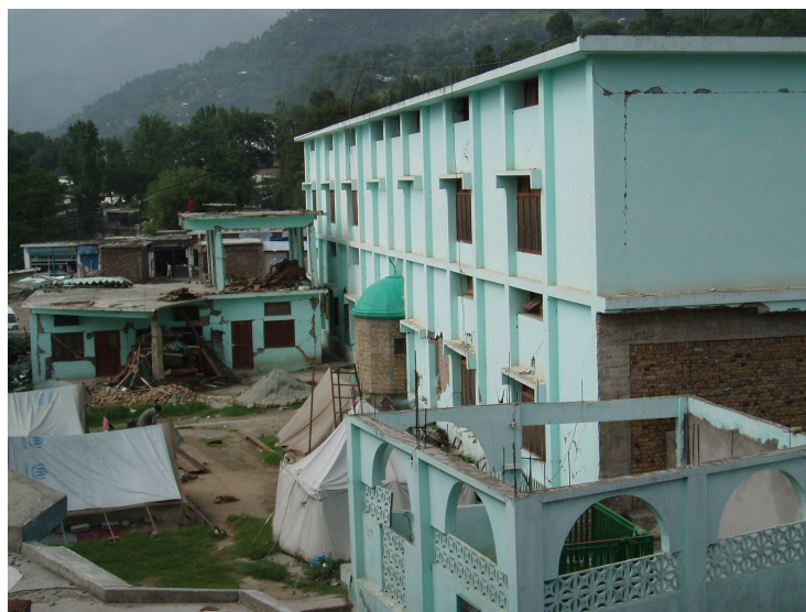
Фото № 6. Восточная окраина жилого района рядом с горами. Равнинная местность. Все голубые здания были построены одной и той же компанией, использованы схожие методы. Минимальное повреждение – несколько обвалившихся стен. 10-20 лет.
