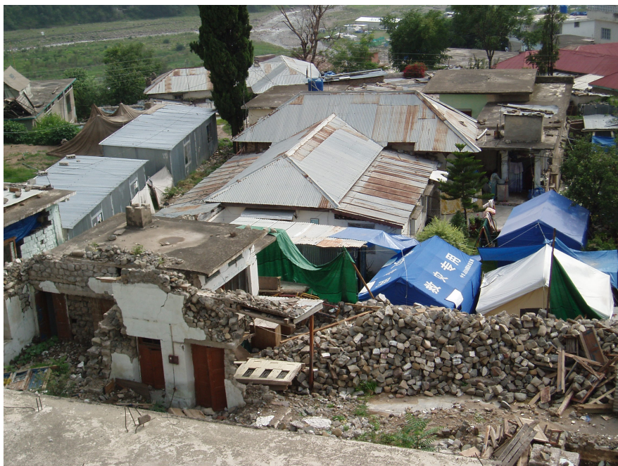
Фото № 7. Западная окраина жилого района около реки. Равнинная местность. Кирпичное здание практически полностью разрушено. Металлические постройки почти не пострадали. 10-30 лет.
