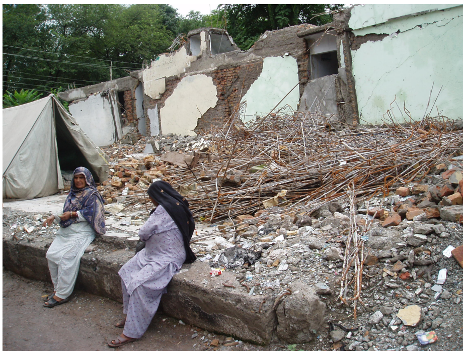
Фото № 2. Старая часть города, неподалеку от древних развалин. Стандартный кирпич. 30-70 лет. Изначально здание было трёхэтажным; задняя стена частично уцелела. Арматура не относится к обвалившемуся зданию.
