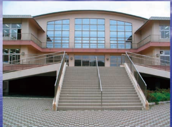
ピロティ構造を採用した小学校
