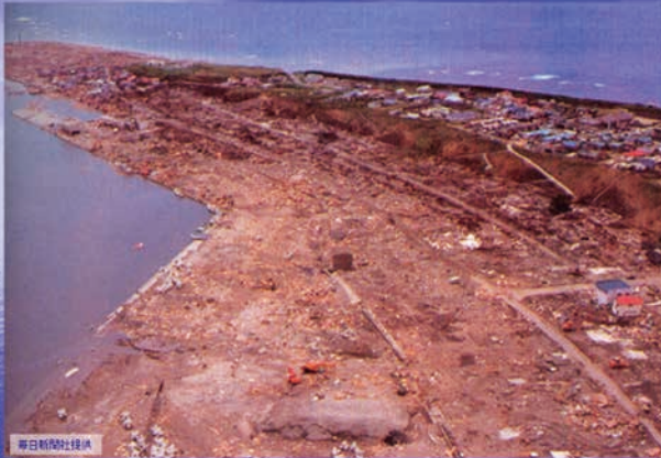
津波被害状況 (青苗地区)
