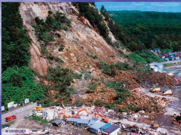
地震による斜面崩壊
