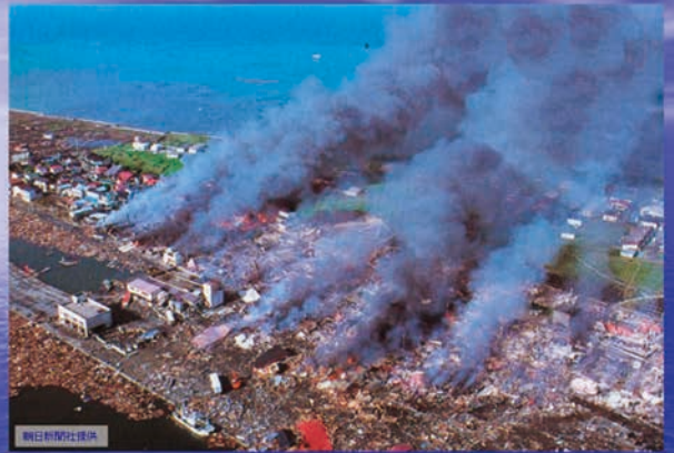
津波来襲後の火災 (青苗地区)
