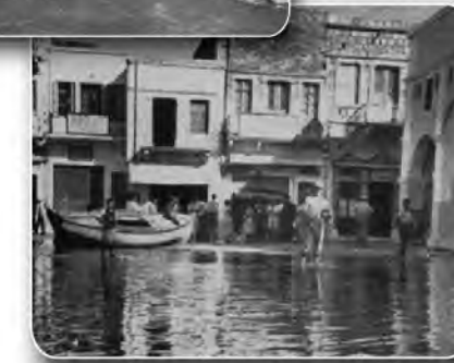
Ζημιές από το τσουνάμι της 9ης Ιουλίου 1956 στην Κάλυμνο και στην Αμοργό (Αγία Πελάγος) (Πηγή: Αρχείο Γεωδυναμικού Ινστιτούτου ΕΕΑ)
