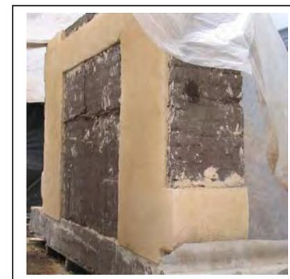
(4) Abrir los orificios para conectores en las proyecciones de las venas de la malla. Los orificios deben quedar espaciados a distancias del orden de 20 cm o menos en las dos direcciones.
