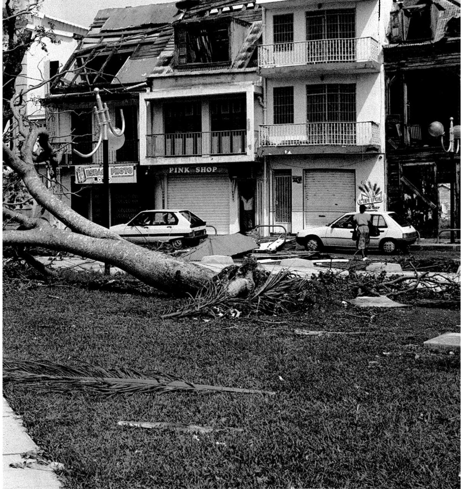
▲ Pointe-à-Pitre, place des Victoires. Même les maisons en dur n'ont pas résisté au passage du cyclone Hugo.
