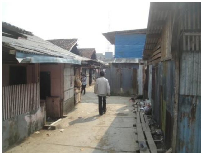
Gambar 3 Material Dinding Bangunan di Lokasi Studi
