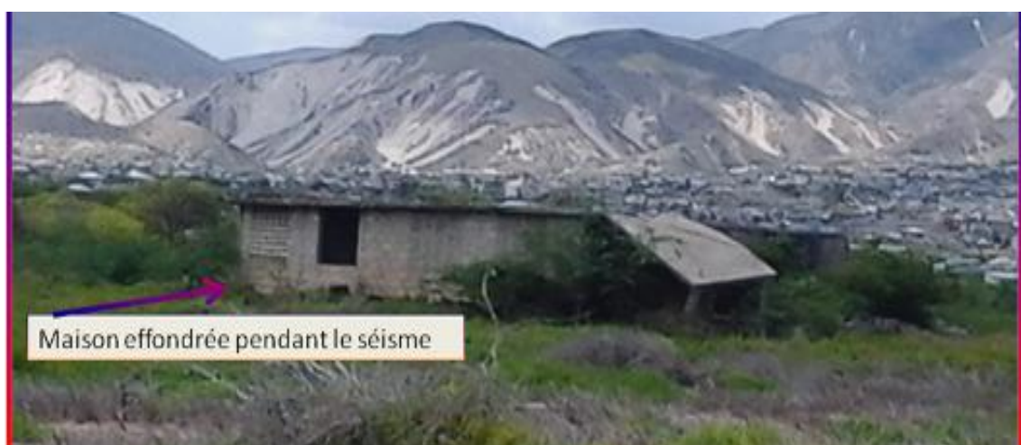
FIG. 24 Maison effondrée pendant le séisme du 12 Janvier 2010 à cause de liquéfaction.
