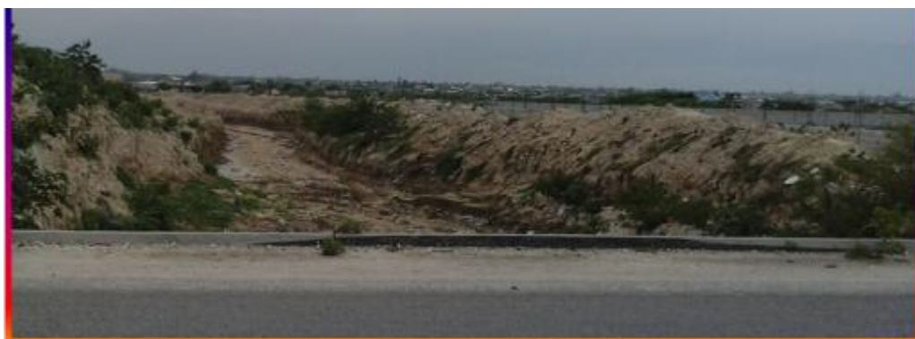
FIG, 73: Canal excavé à côté du camp de Corail.
