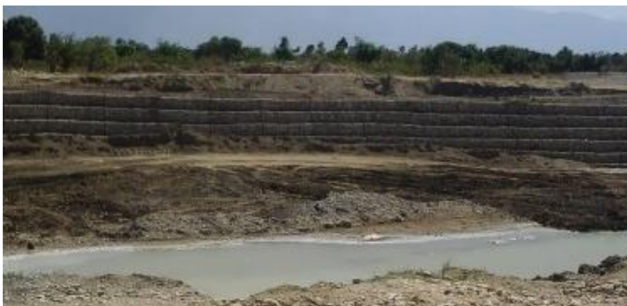
FIG. 54 Gabion dans la rivière Grise.
