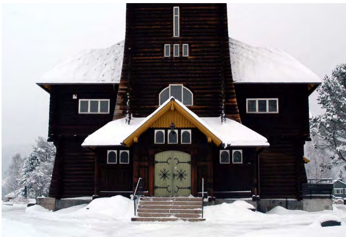
KULTURMINNE. Trekirke på Rena, et viktig kulturminne i Norge som trues av ekstremvær og økt luftfuktighet (Foto: Ilan Kelman)
