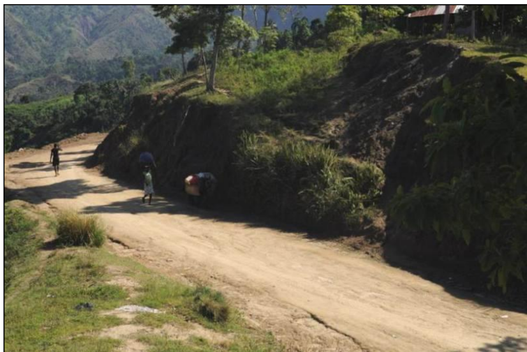
Fig. 22 Route de Beatrice: le découpage de route est un facteur prédisposant à l'instabilité des pentes.
