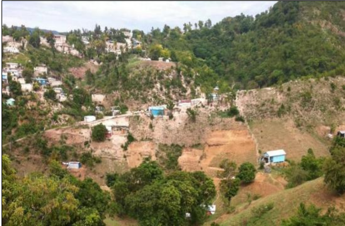
Fig. 3 Plusieurs abris des ong et maison construites dans les zones à haut susceptibilité aux débris flow (rivière La Digue, Petit Goâve)
