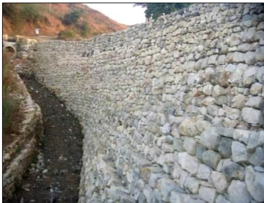
Fig. 13 Ouvrages pour protéger la route de Beatrice (Petit Goâve) de l'érosion causée par l'évolution en rétrogression des débris flow.
