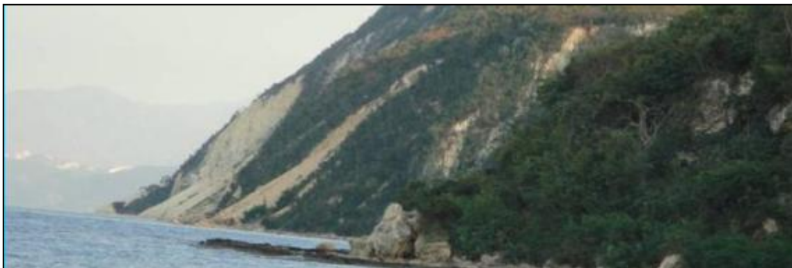
Fig. 54 Éboulements activés pendant le séisme du 12 Janvier 2012, dans la côte de Tapion.
