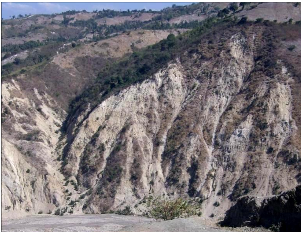
Fig. 6 Débris flow à Petit Goâve dans la 9eme Section.
