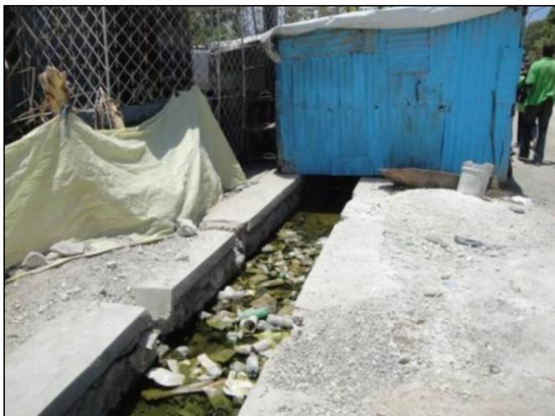
Fig. 24 Canal de drainage obstrué par les déchets,
