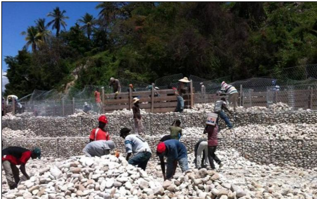
Fig. 52 Gabionnage en construction dans la rivière La Gosseline dans la zone de l'hôpital.
