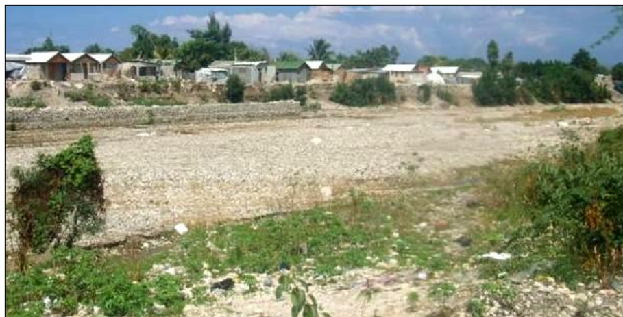
Fig. 33 Érosion des berges dans la rivière de Grand Goâve.
