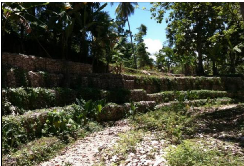
Fig. 44 Gabionnage dans la rivière des Orangers à Bas Cap Rouge.
