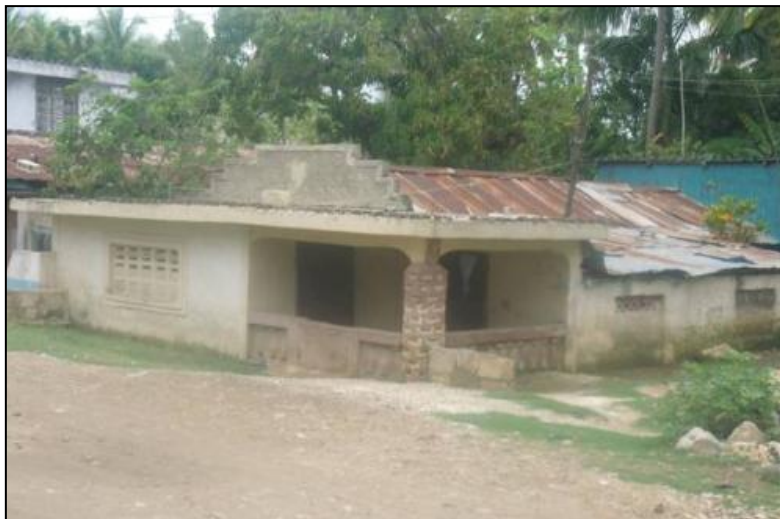
Fig. 23 Rivière Cayman "localité Petit Guinée à PETIT GOÂVE: maisons recouvertes d'alluvions.
