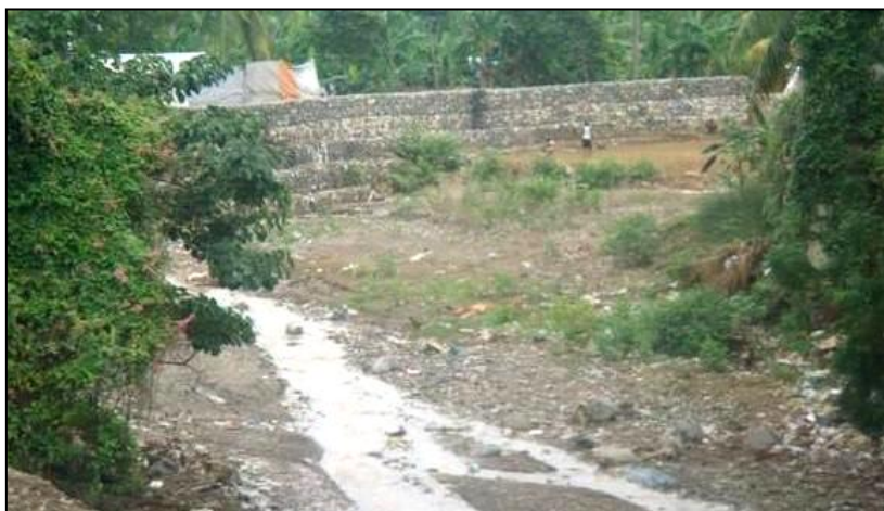
Fig. 21 Gabionnage construit par WHH/ECHO dans la Rivière Cayman.
