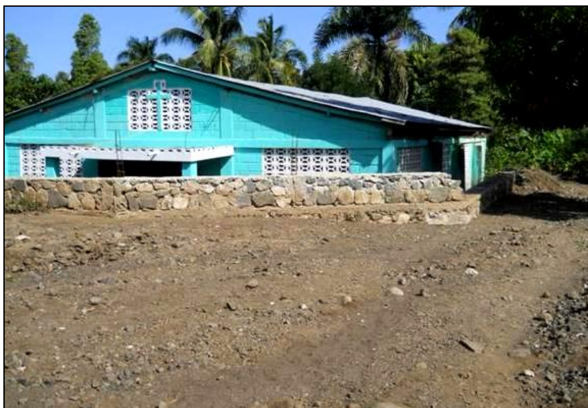
Fig. 25 Le mur de protection a protégé la maison des inondations (zone de Violet).
