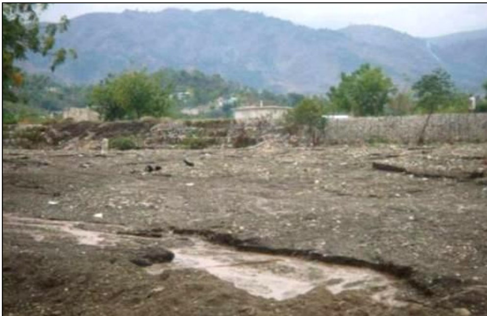
Fig. 14 En haut la Rivière La Digue localité Borne Soldat: orthophoto* 2010: brèches (ouvertures) dans la gabionnage et la photo des correspondantes brèches en bas (Source Lentini Azzurra, WHH).
