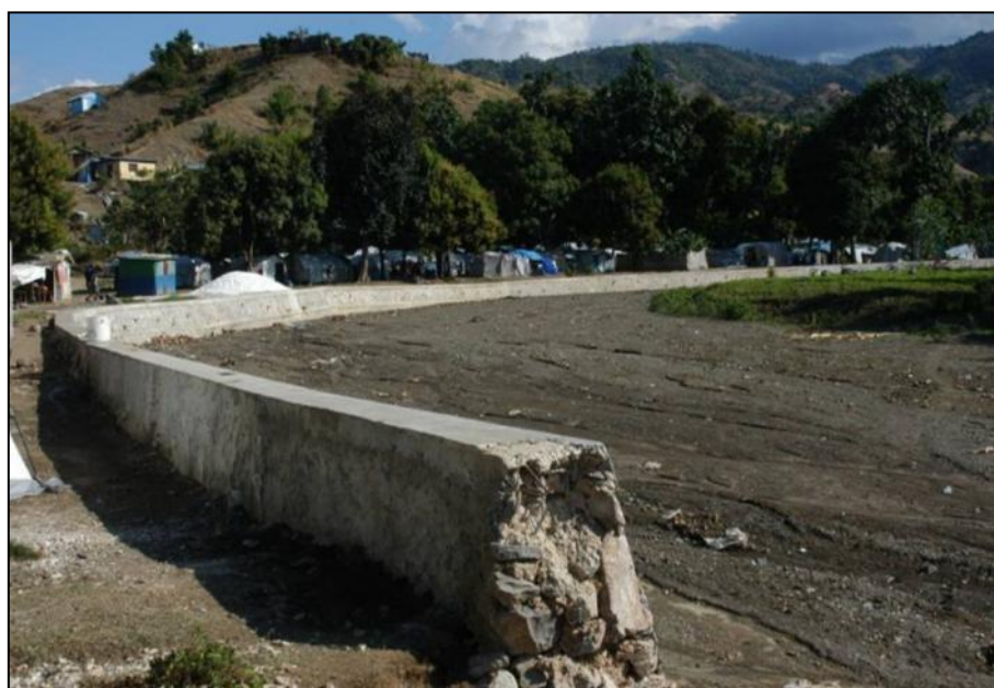
Fig. 17 Zone de Nan Regal, mur de protection construit pour protéger le camp.
