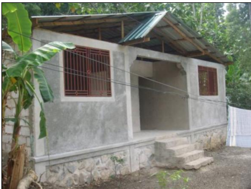
Fig. 12 Localité Fon Fabre nouvelles maisons en construction.
