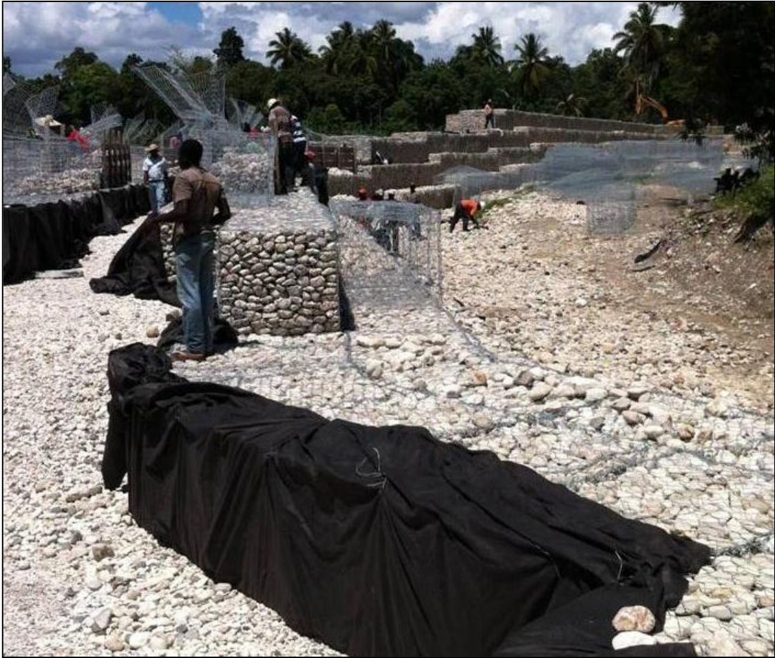
Fig. 53 Gabionnage en construction dans la rivière La Gosseline dans la zone de l'hôpital.
