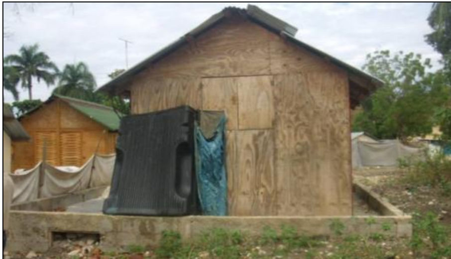
Fig. 11 Localité FON FABRE: maison construite par des ONG, sur la toiture d'une vieille maison recouverte par alluvions.
