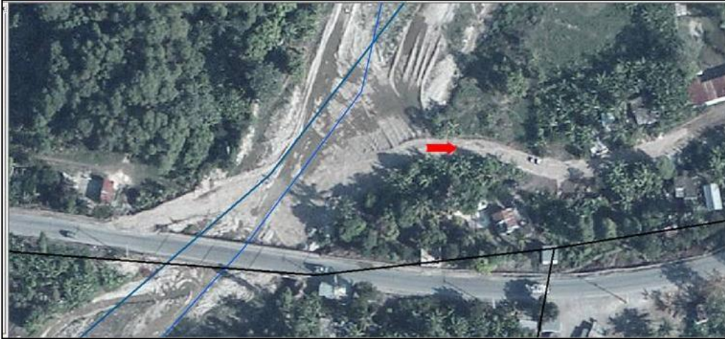
Fig. 37 Orthofoto de l'érosion de berges dans la rivière Lavagne, en correspondance du pont de la route Nationale.
