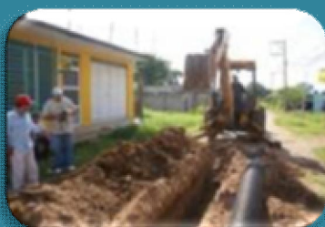
Mejora del drenaje perimetral de aguas lluvias
