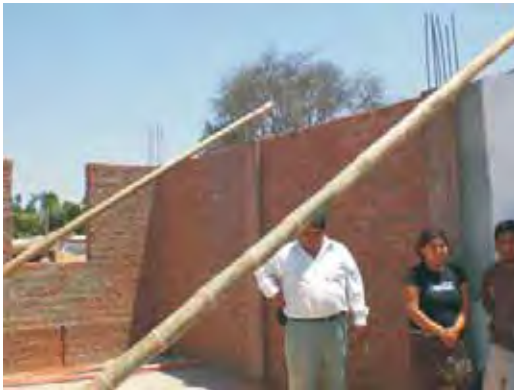
>>Fig 4.1 Vivienda de albañilería en la que se está iniciando el techado con elementos livianos de vigas de bambú y caña, pero sin viga collar. Lugar: Comatrana, Ica, fecha: 11 de diciembre de 2008. Ubicación en F-5.1 .
