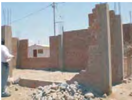
>>Fig 3.5 Falla de un muro por la flexión ocasionada por la falta de confinamiento superior con viga collar. El mayor desplazamiento ocurrió en el vértice del triángulo superior izquierdo y se produjo el colapso del muro. Comatrana, lca. 15/08/2007. Ubicación en F-5.1 .
