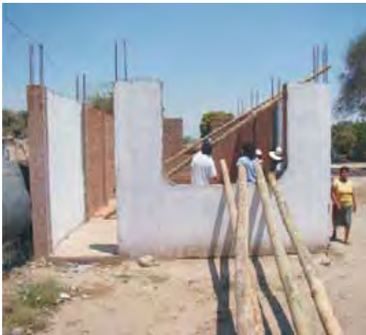
>>Fig 4.2 Otro ángulo de la misma vivienda. En esta imagen se observa cómo se le está explicando al propietario - constructor la necesidad de colocar primero la viga collar en todo el perímetro de la vivienda y sólo después instalar el techo ligero de bambú y caña chancada.
