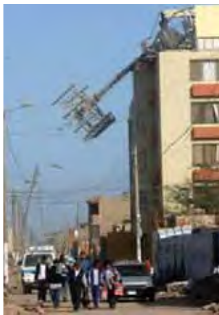
>>F-4.11 Colapso de una torre de telecomunicaciones, en Pisco.
