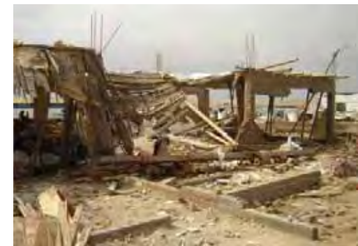
>>F-4.13 Daños provocados por el tsunami que afectó la zona de Lagunillas, en Pisco, y destruyó el terminal pesquero.
