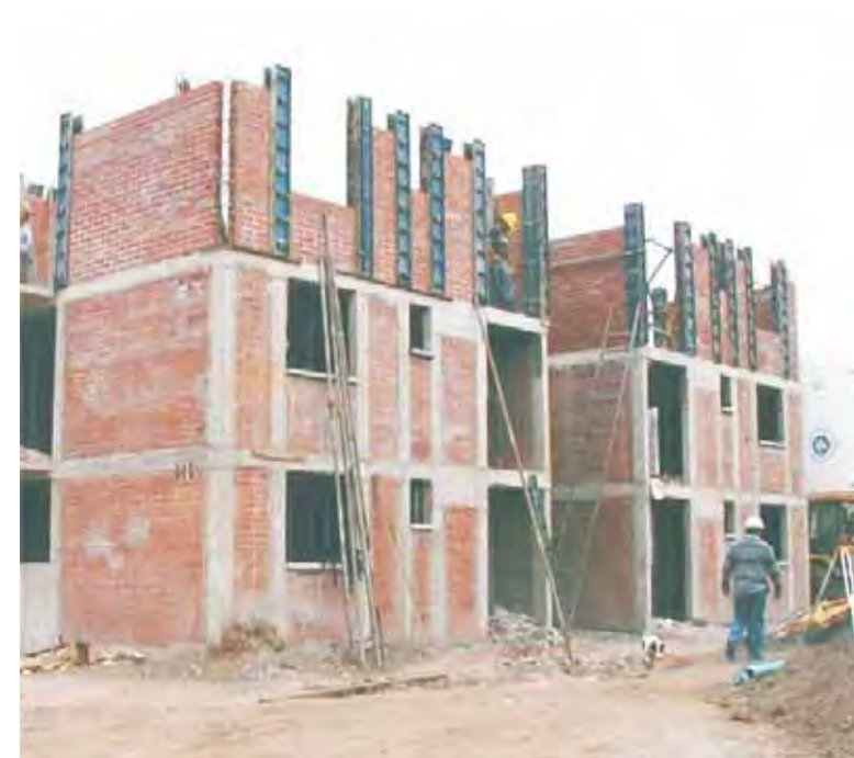
>> F-2.1b Albañilería confinada en proceso constructivo.
