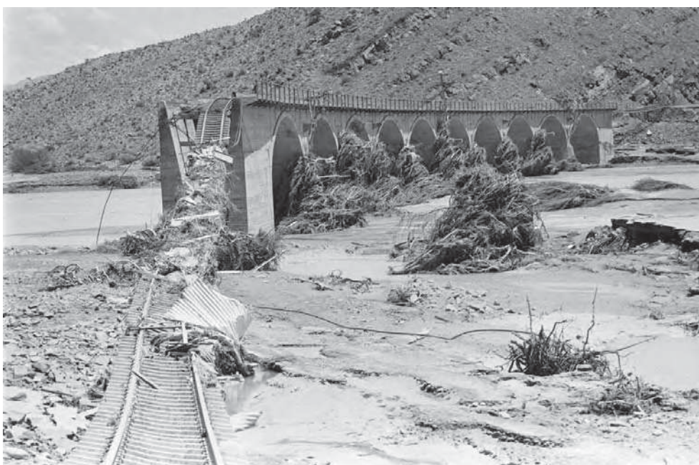
Skade gely deur die spoorweg brug na die 1981 vloede in Laingsburg toe die Buffelsrivier oorstrom, en meer as 100 lewens geëis het.
