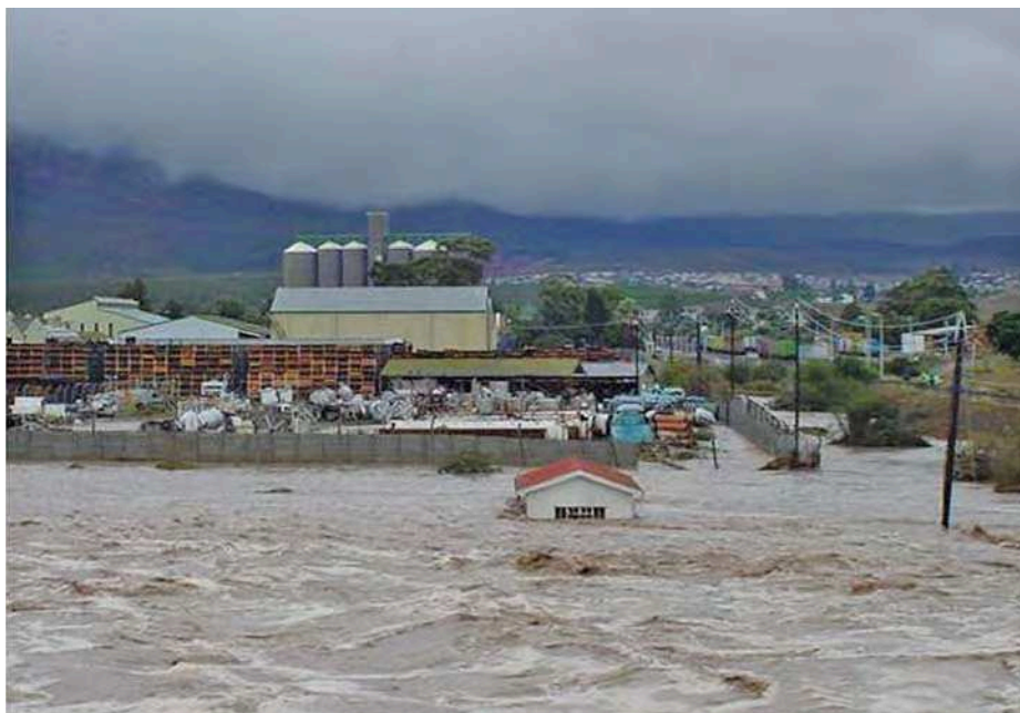
Hewige oorstroming in Ashton volg op die 'Montagu vloed' van Maart 2003. Hierdie gebeurtenis was nie slegs rampspoedig weens die skade aan infrastruktuur en landbou nie, maar dit het ook die plaaslike lewensbestaan ontwig as gevolg van skade aan plaaslike inmaakfabrieke.
