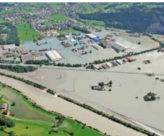
Crues de 2005: inondations à Schattdorf UR (Forces aériennes suisses)
