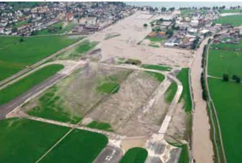
Décharge des eaux à Buochs NW le 23 août 2005 (Forces aériennes suisses)
