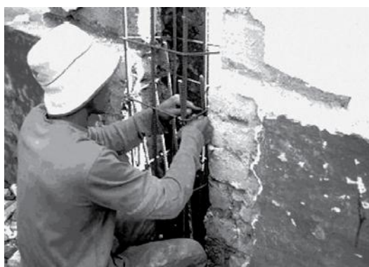
图15：印度尼西亚学校的抗震改建
