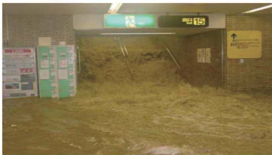
地下街の浸水状況 H15.7福岡水害 (博多駅)
