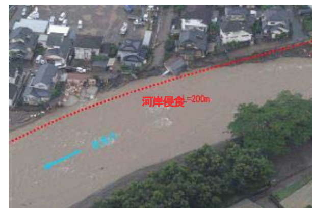
河岸侵食に伴う家屋倒壊
