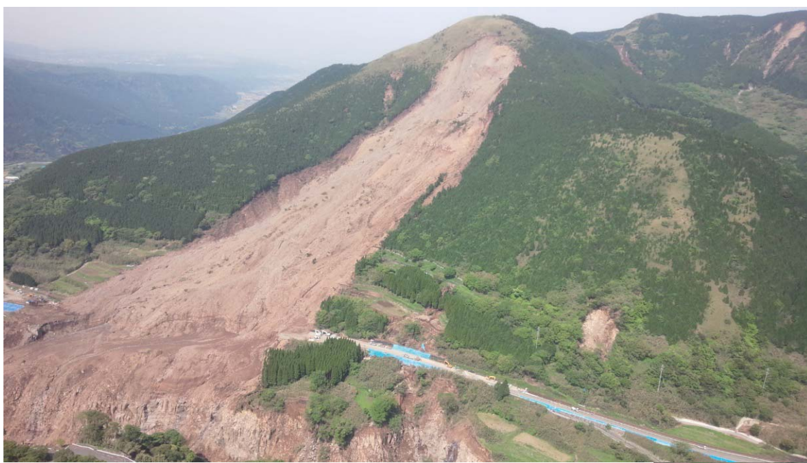
阿蘇大橋崩落現場(5月5日)
